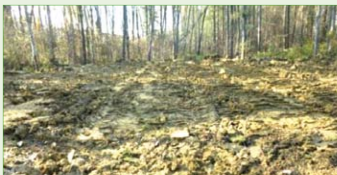
Ablagerung und Zwischenlagerung von Aushubmaterial
